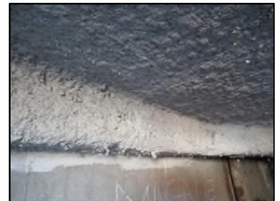
Photo N° 662 AMIANTE CIMENT -- LOCAL POUBELLE Conduits Ventilation haute (Fibres-ciment)
